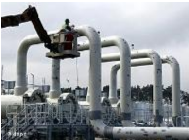
Conexión del gasoducto Nordstream con las tuberías en tierra.
